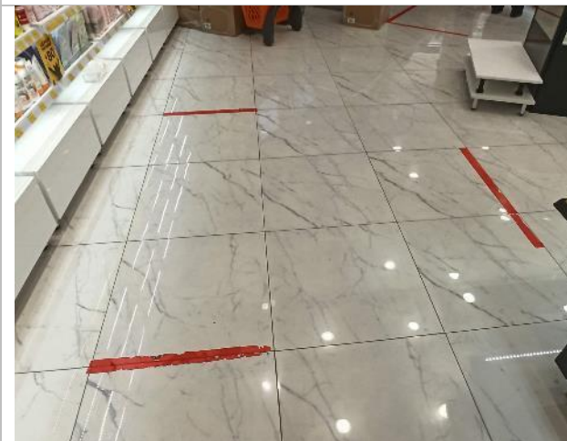
Фото 35. Внутреннее состояние помещения
