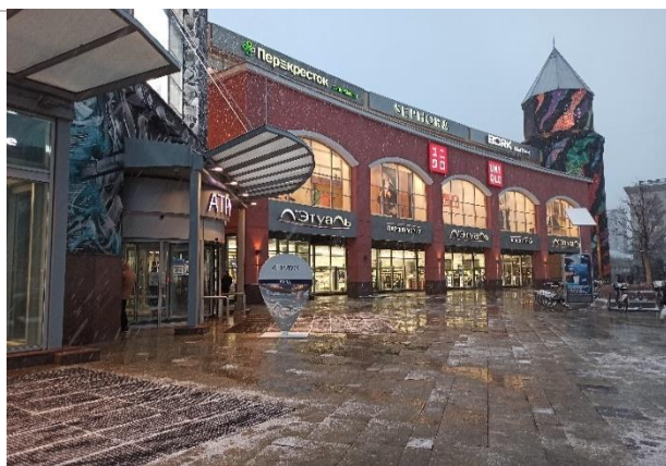
Фотография 3.1. Внешний вид здания
