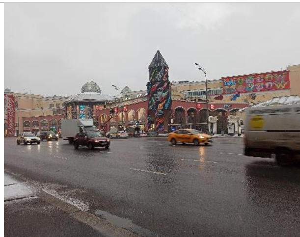
Фото 6. Фасад здания, подъездные пути
